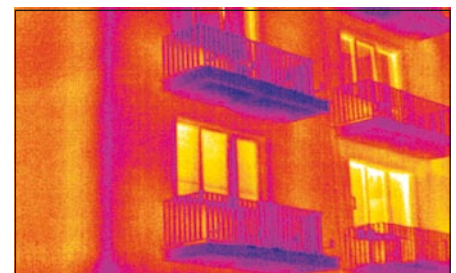
Wychłodzona płyta balkonu przy spadku temperatury (dom nieocieplony)
