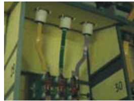
Rozdzielnia SN. Wada przyłącza szynowego do odłącznika
