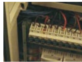
Rozdzielnia nn. Wada złącza do wyłącznika nadmiarowo-prądowego
