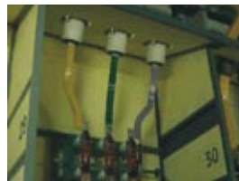
Rozdzielnia SN. Wada przyłącza szynowego do odłącznika
