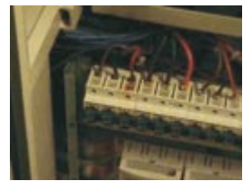
Rozdzielnia nn. Wada złącza do wyłącznika nadmiarowo-prądowego
