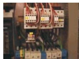
Rozdzielnia nn. Wysoka temperatura przewodów łączących aparaty elektryczne
