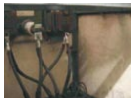
Rozdzielnia nn. Wada przyłącza kablowego do przekładnika
