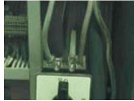
Rozdzielnia nn. Przegrzanie przyłącza do wyłącznika ok. 23K
