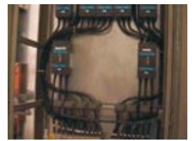
Rozdzielnia nn. Duże obciążenie prądowe powoduje nadmierny wzrost temperatury wiązki kabli
