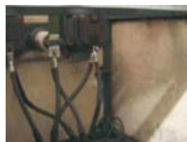
Rozdzielnia nn. Wada przyłącza kablowego do przekładnika
