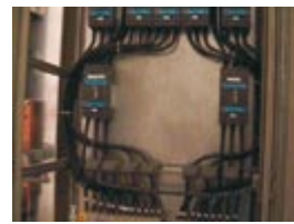
Rozdzielnia nn. Duże obciążenie prądowe powoduje nadmierny wzrost temperatury wiązki kabli
