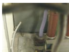
Rozdzielnia SN. Wada przepustu w podłożu lub złącza pod sufitem na poziomie II
