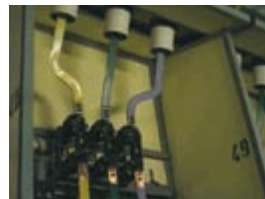
Rozdzielnia SN. Wada przyłącza szynowego do odłącznika
