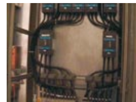
Rozdzielnia nn. Duże obciążenie prądowe powoduje nadmierny wzrost temperatury wiązki kabli
