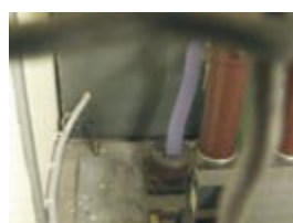
Rozdzielnia SN. Wada przepustu w podłożu lub złącza pod sufitem na poziomie II
