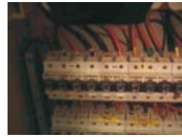
Rozdzielnia nn. Wada złącza do wyłącznika nadmiarowo-prądowego
