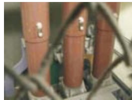
Rozdzielnia SN. Wada przyłącza do kolumny wyłącznika olejowego
