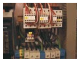
Rozdzielnia nn. Wysoka temperatura przewodów łączących aparaty elektryczne
