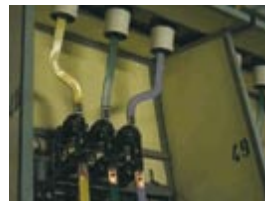
Rozdzielnia SN. Wada przyłącza szynowego do odłącznika
